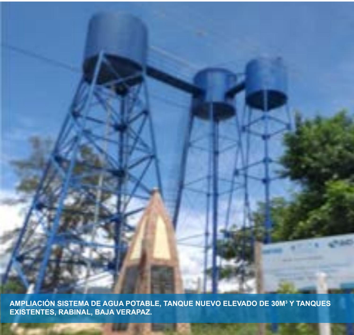
**AMPLIACIÓN SISTEMA DE AGUA POTABLE, TANQUE NUEVO ELEVADO DE 30M<sup>3</sup> Y TANQUES EXISTENTES, RABINAL, BAJA VERAPAZ.**
