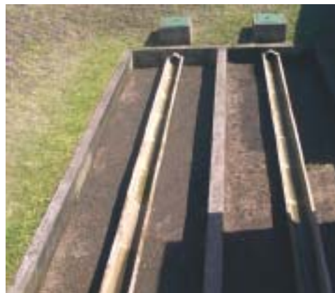
Lechos para el secado de lodos en planta para el tratamiento de aguas residuales en Urb. Bosques de Santa Ana, San José, Costa Rica. Fotografía tomada por unidad Aguas residuales del AyA, Costa Rica
