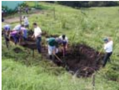
Excavación del sitio donde se colocará el biofiltro
