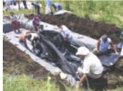
Colocación de materiales impermeabilizantes en fondo de
