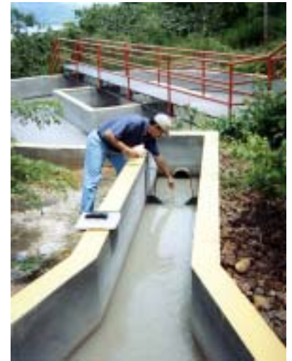
Medición de caudal con vertedero de pared delgada. Suchitoto, El Salvador Foto cortesía de Doreen Salazar
